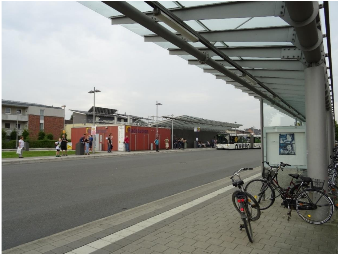
Beispiel Radstation Warendorf (Quelle: eigene Aufnahme)
