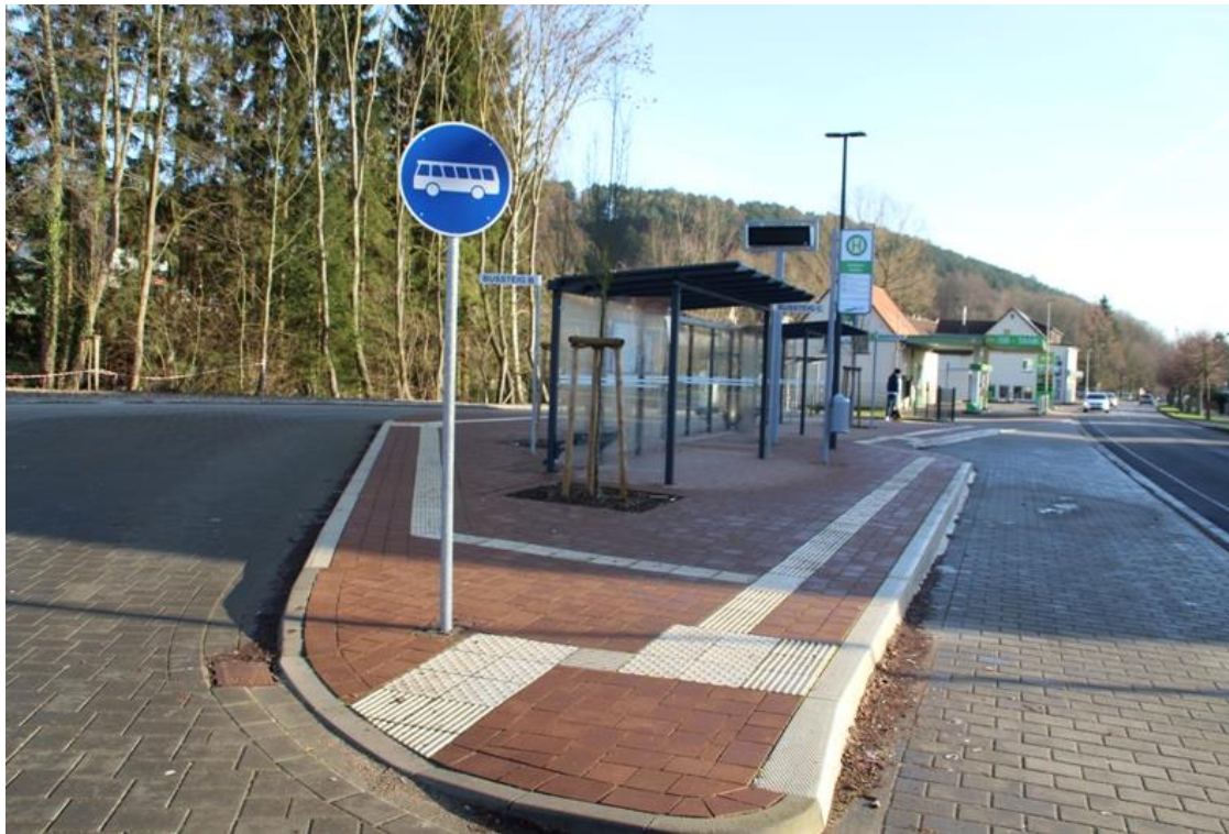
beispielhafte Ausstattung einer barrierefreien Gestaltung einer Bushaltestelle inkl. Zuwegung – eigene Aufnahme
