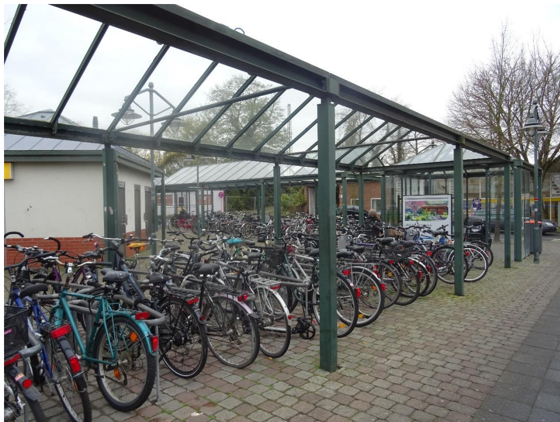
Radabstellanlage Bahnhof Ahlen – eigene Aufnahme
